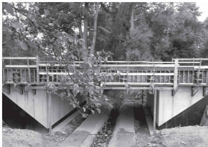
Obě tělesa nových mostků ve fázi technologické přestávky, vlevo strouha v zatáčce, vpravo Zborovský potok
