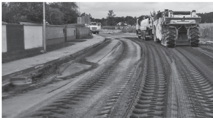
Těžká technika při mletí, cementování a hutnění podkladové vrstvy v okolí autobusové zastávky.
