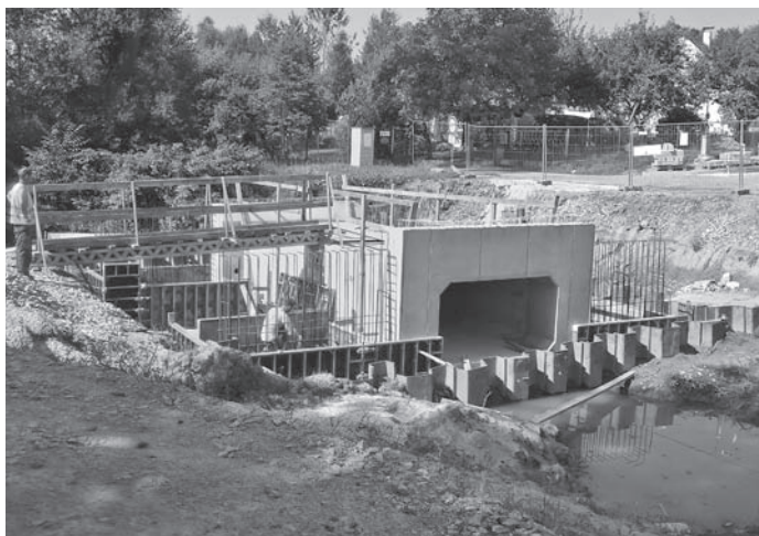
Obě tělesa nových mostků ve fázi technologické přestávky, vlevo strouha v zatáčce, vpravo Zborovský potok
