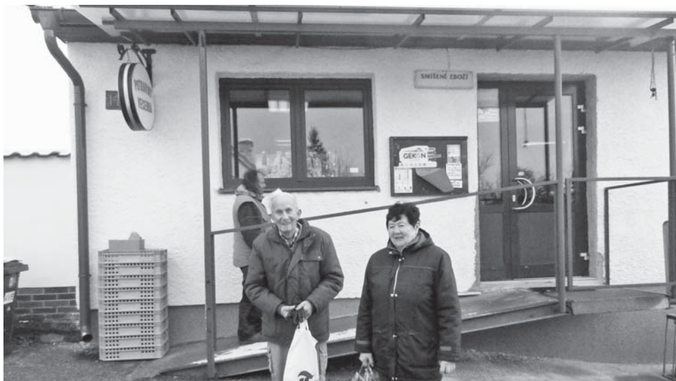
Věříme, že nově zrekonstruovaný vchod do obchodu přispěje k větší spokojenosti nejen místních obyvatel.
